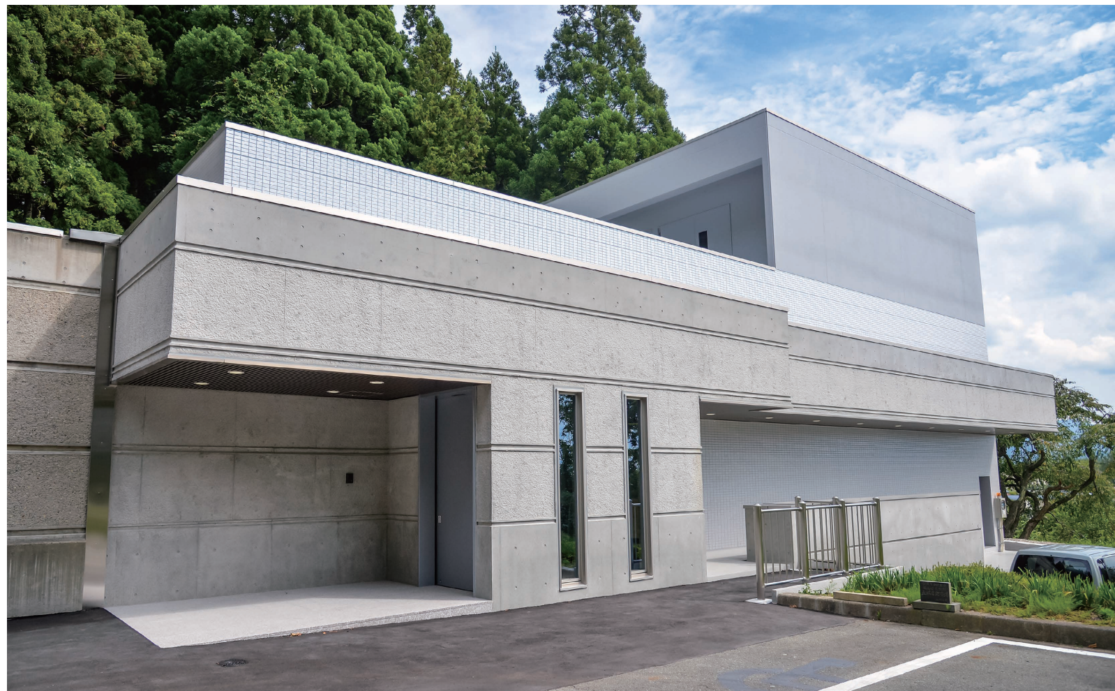
今後見込まれる火葬需要の増加に対応するべく、既存建物の隣に新たな棟を増築。昨年8月から供用を開始しています。
